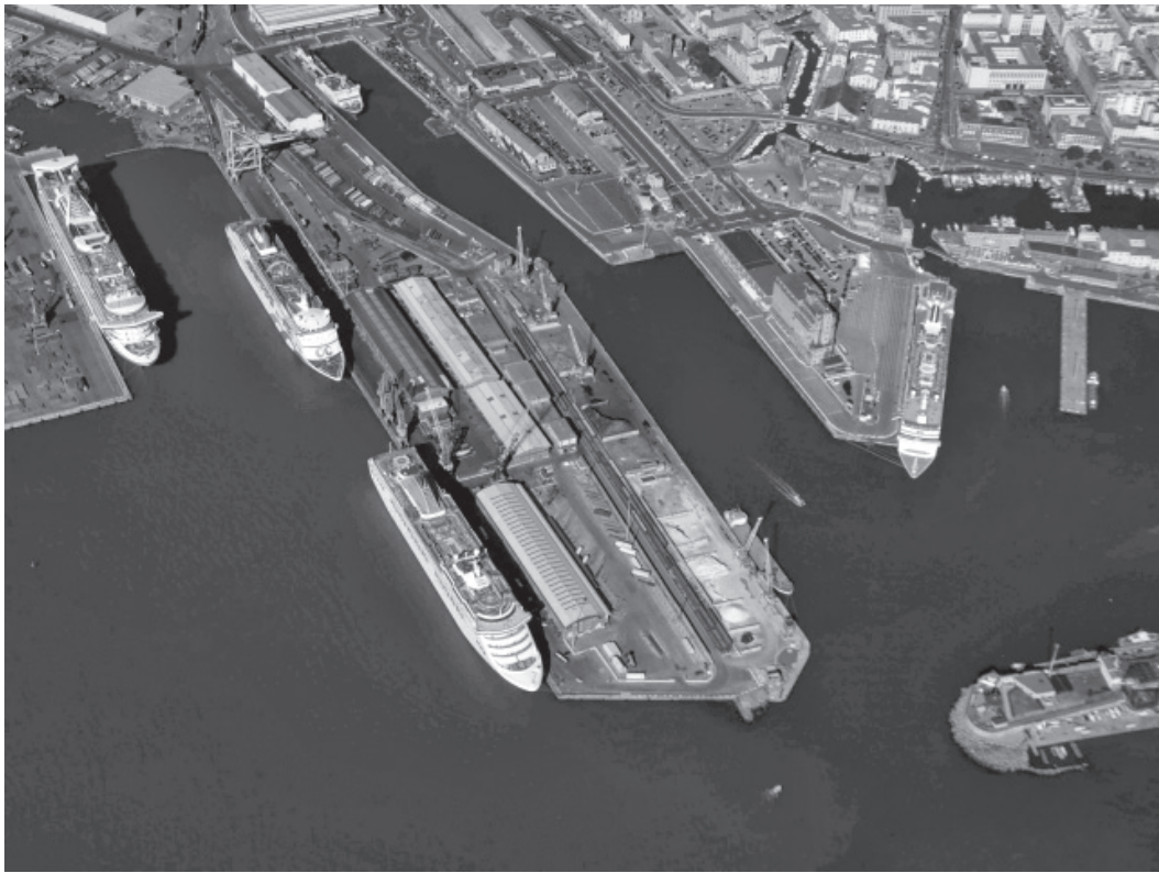
Nella foto: Il terminal dove dovrà sorgere il nuovo centro della Porto 2000.
