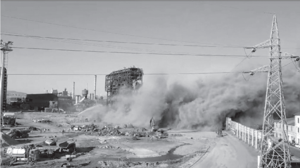
Nella foto: Un momento delle demolizioni.
