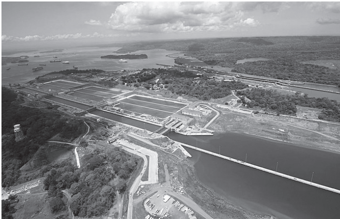
Nella foto: Un tratto del canale di Panama.
