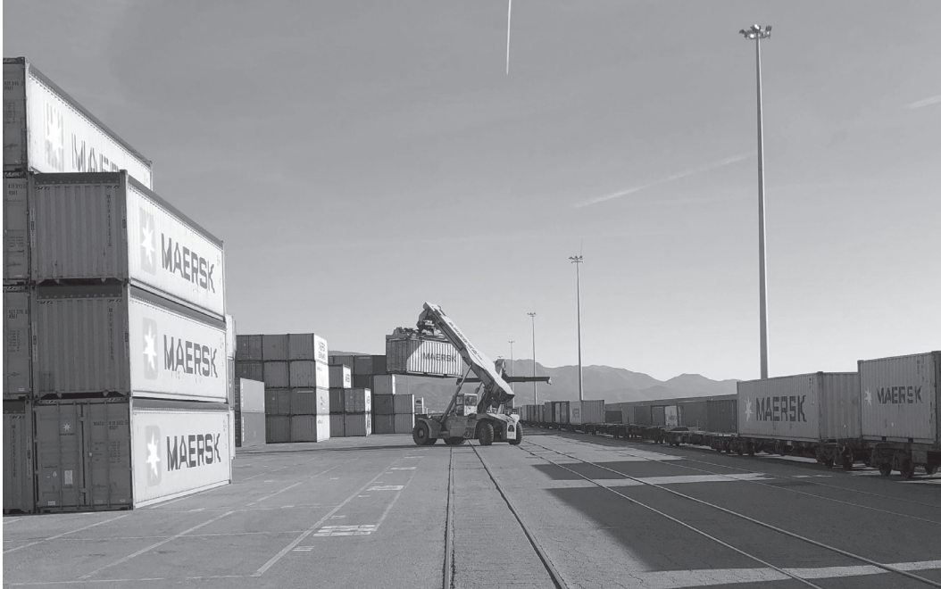
Nella foto: Nuovo collegamento ferroviario sistema portuale Vado Gateway - scalo di Verona Porta Nuova.
