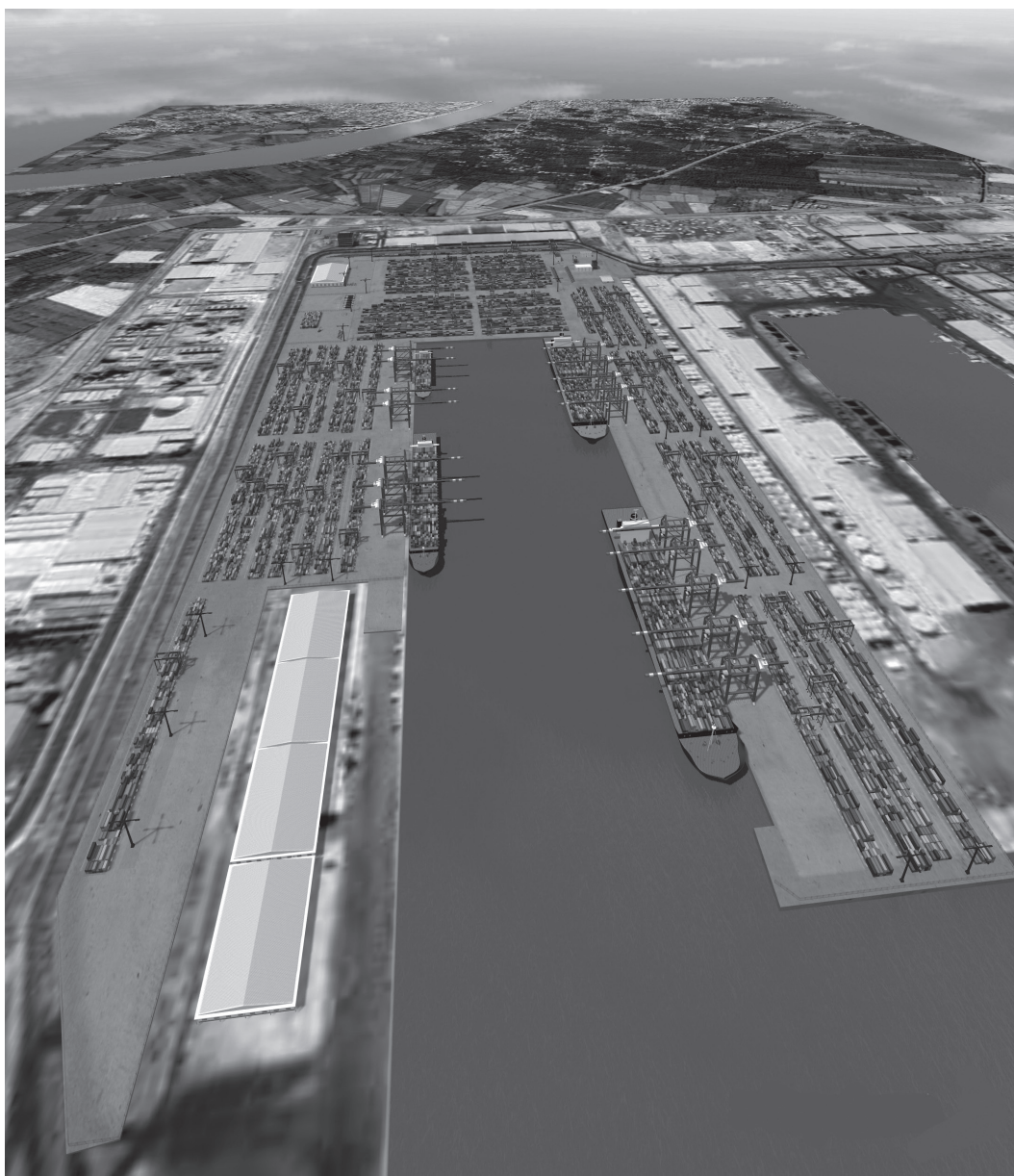
Nell'immagine: Il nuovo Terminal.
