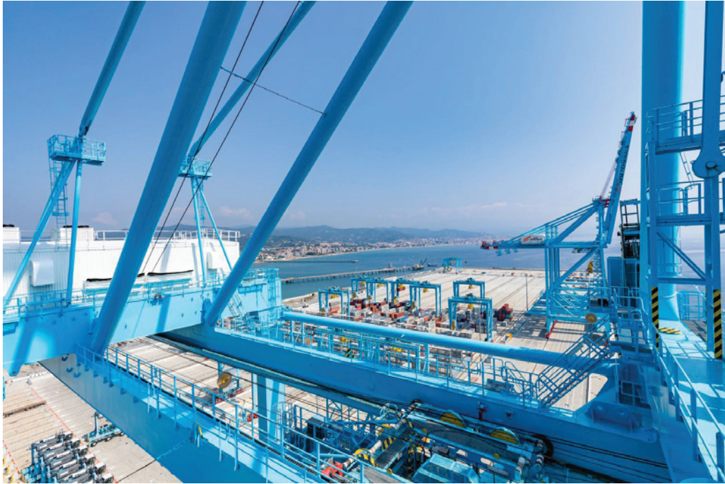
Nella foto: Una fotografia dello yard automatizzato del nuovo Container Terminal di Vado Gateway.
