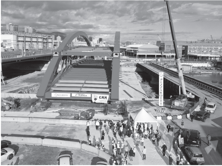
Nella foto: Il ponte durante il posizionamento.
