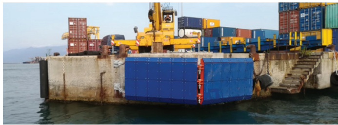
Nella foto: Un «protettore» angolare di banchina tra i nuovi installati.
