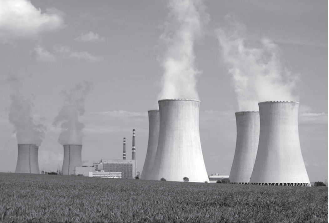
Nella foto: Una centrale di ultima generazione.
