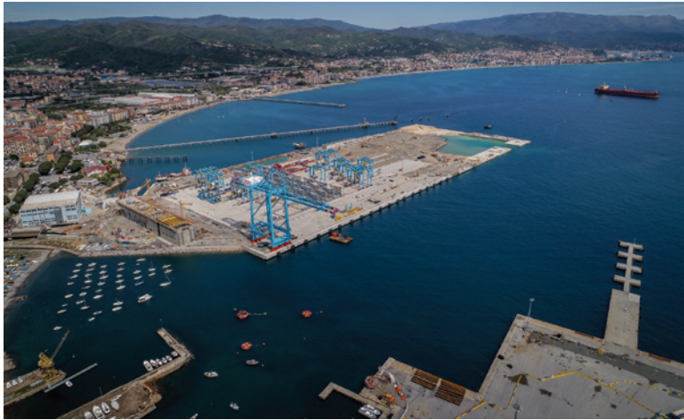
Nella foto: Un'immagine del cantiere di Vado Ligure.
