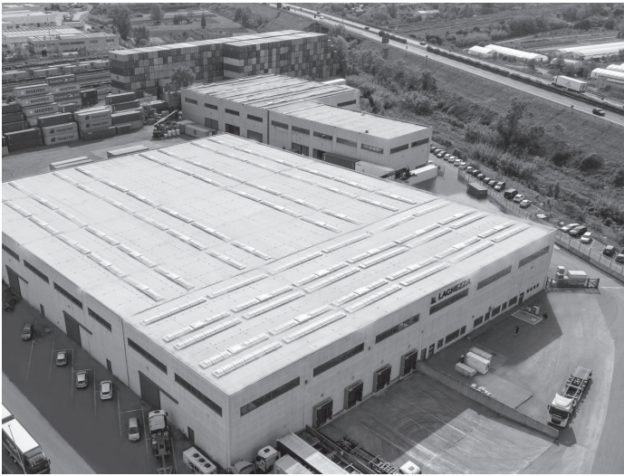
Nella foto: Un aspetto del nuovo Terminal Laghezza.
