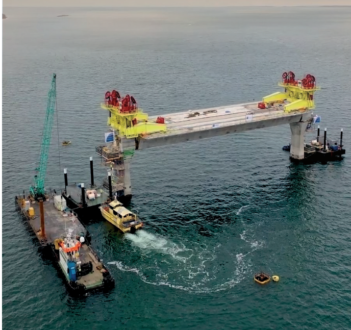
Nella foto: Installazione di strutture Offshore.
