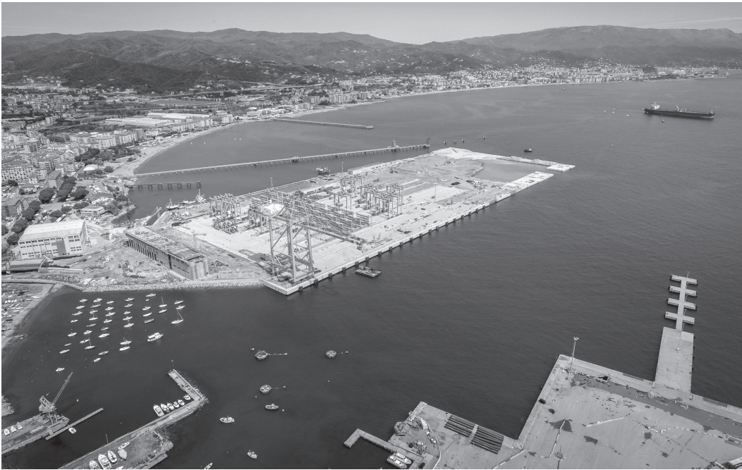
Nella foto: Un’immagine del cantiere di Vado Ligure.
