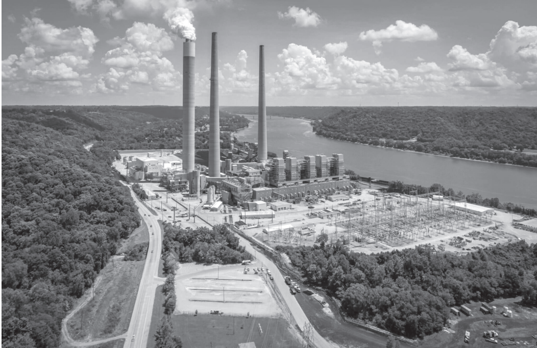
Nella foto: Una centrale elettrica in Germania.
