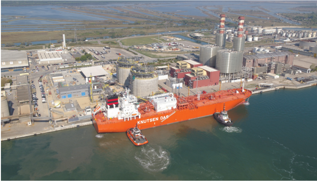
Nella foto: L'impianto appena inaugurato da Edison a Ravenna.
