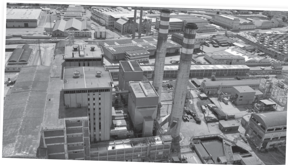
La centrale Enel.
